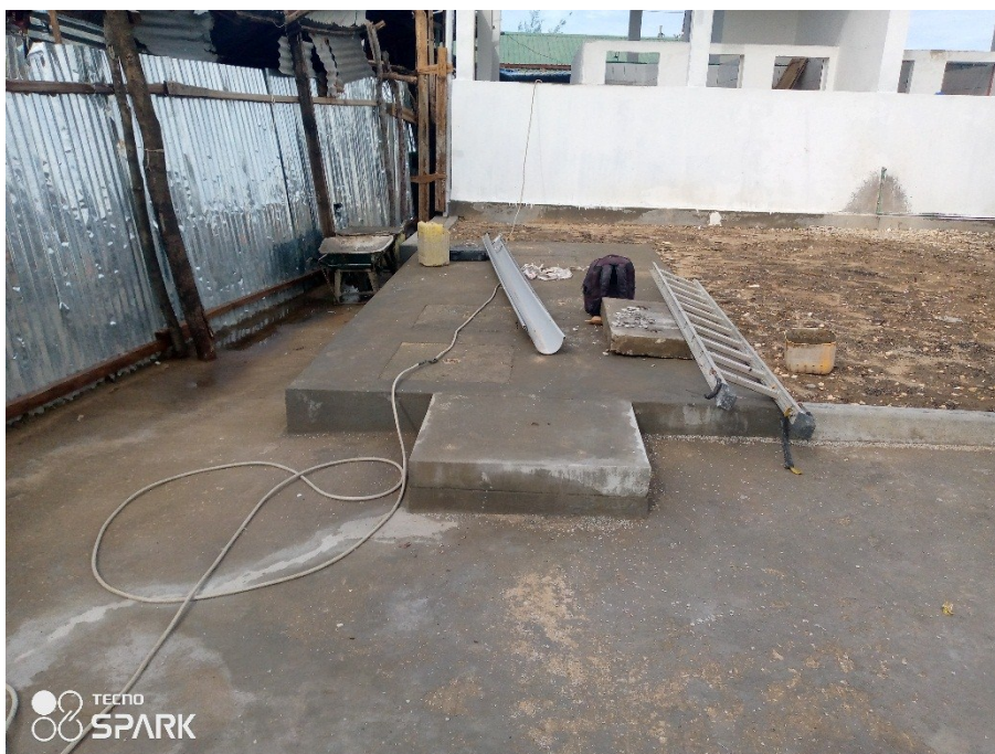
Fosse septique du bloc sanitaire
