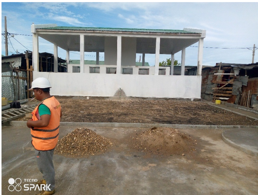
Façade postérieure du bloc sanitaire 2 et l'espace vert réservé pour l'implantation d'arbre
