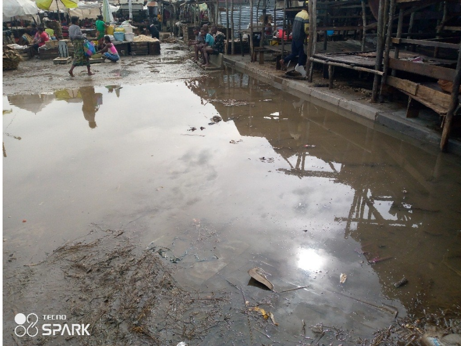
Stagnation d'eau au regard absorbant plein (demi-chaussée)
