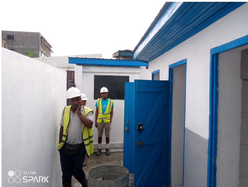
Façade principale du bloc sanitaire et du guérit
