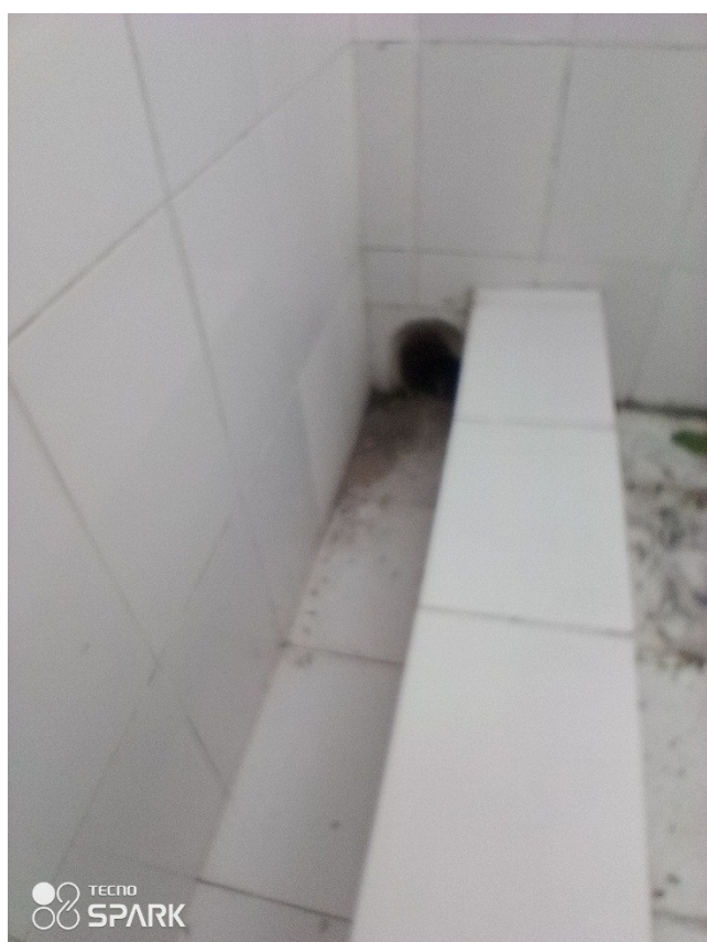
Urinoir du bloc sanitaire à la façade postérieure
