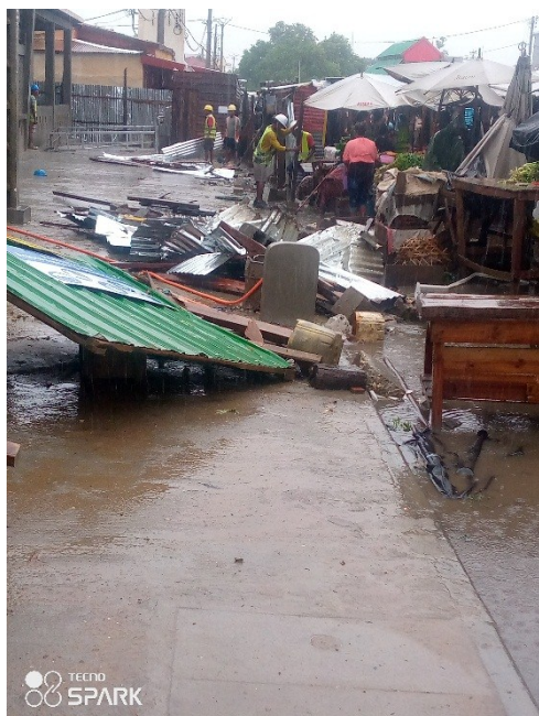
Clôture de chantier endommagée
